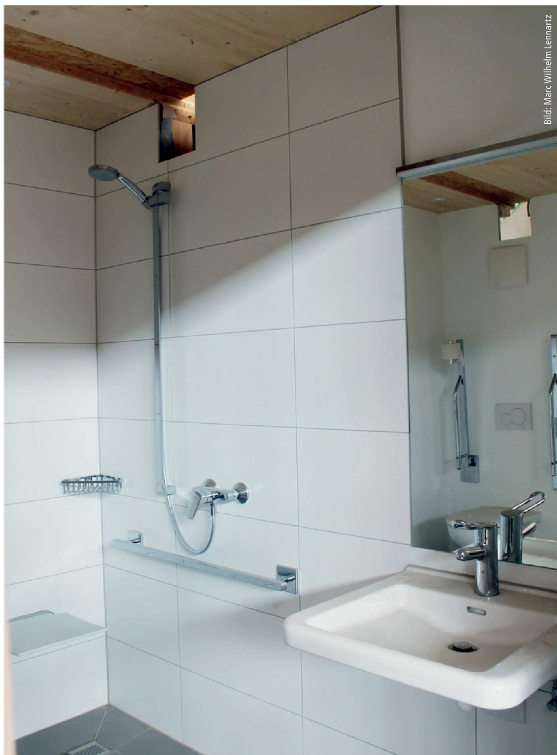
Für das Studentenwohnheim hat Schütt Holzbau 66 Nasszellen in drei Größen inklusive Waschbecken, Toilette und Dusche, Wand- und Bodenfliesen komplett werkseitig vorproduziert.
