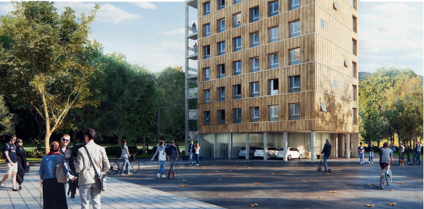
Der „Neue Ellener Hof“ soll eine Art Modellquartier für Bremen werden, ein urbanes Dorf mit einem möglichst breiten Spektrum an Bewohnern, die ihre kurzen Wege emissionsfrei bewältigen können.
