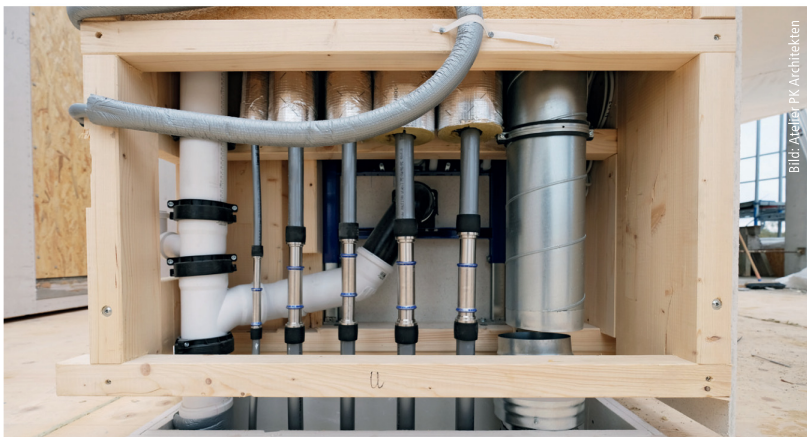
Die gesamte Installationsebene wird in der Montage bereits in den Wandaufbau integriert. Die zwischen 2 bis 3 wiegenden Badmodule werden dann auf der Baustelle in die vorbereiteten Wohneinheiten eingehoben und angeschlossen.
