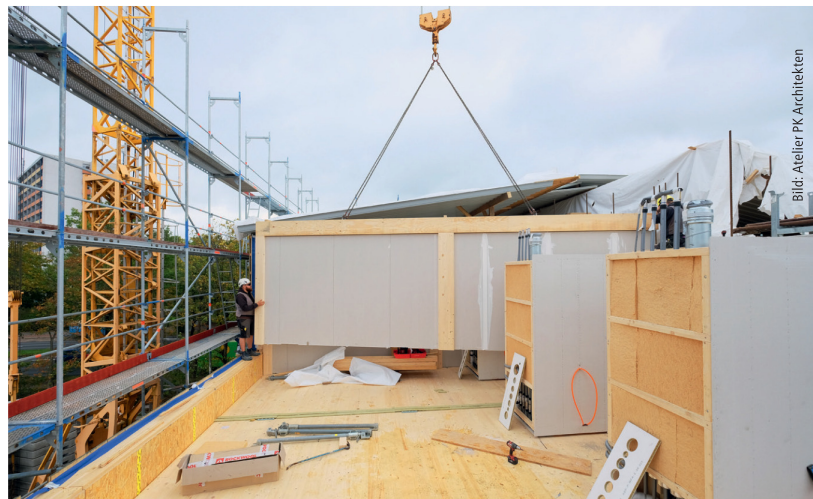
Die vorproduzierten, tragenden Wohnungstrennwände bestehen aus zwei mineralisch gedämmten KVH-Rahmen von je 9 cm, die von einer geschlossenen und mineralisch gedämmten Schallschutzfuge von 2 cm separiert werden.
