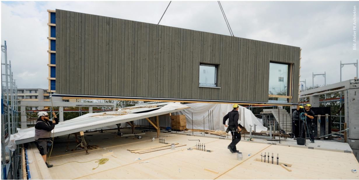
Die nicht tragenden Außenwände in Holztafelbauweise wurden komplett inklusive Dämmebene, Fassadenbekleidung, Durchfensterung und montiertem Brandriegel angeliefert.
